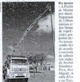
Caminhão Muncil no serviço de manutenção das lâmpadas.
